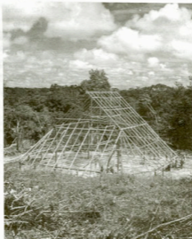
Maloca en construcción. (Fotografía: Fernando Urbina)
